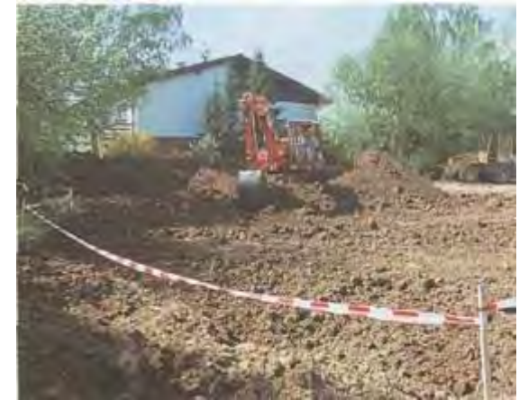
Границы котлована размечены: растительный слой земли снимается и складывается отдельно.
