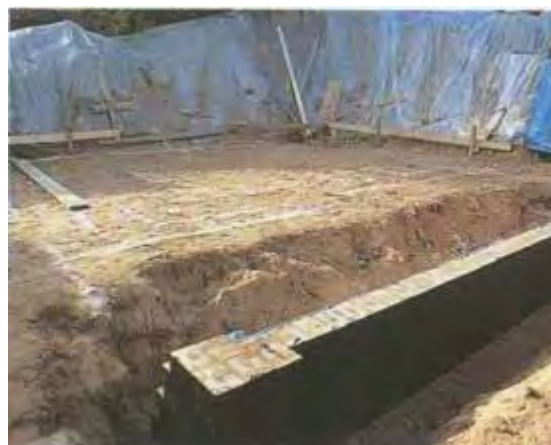
24 октября: боковой ленточный фундамент возведен и гидроизолирован.
