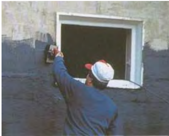
Для гидроизоляции стены наносится тройной слой битумной краски.
