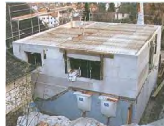
14 ноября, восьмой рабочий день: после одного дня проливного дождя лежит перекрытие первого этажа.
