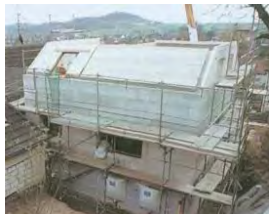
21 ноября, двенадцатый рабочий день: уложены плиты монолитной крыши.
