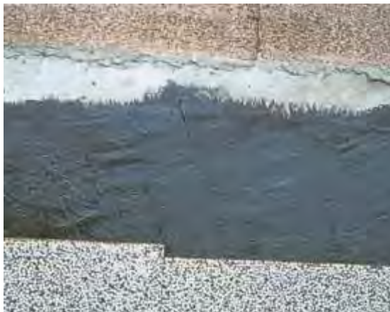
Послойный срез. Важно: до установки дренажных плит должен наноситься ваточный холст.
