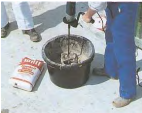
Лопастной мешалкой замешивается раствор.
