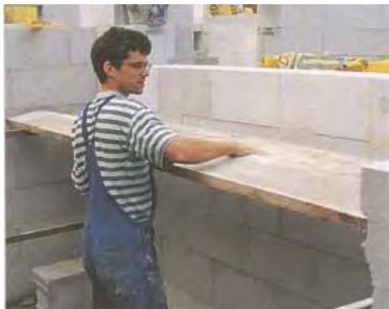
Уже пора ставить надежные подмости, чтобы
