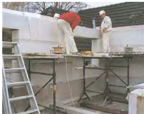
...с трех сторон. Устанавливаются коробки для шторных ставней и облицовывается край перекрытия.
