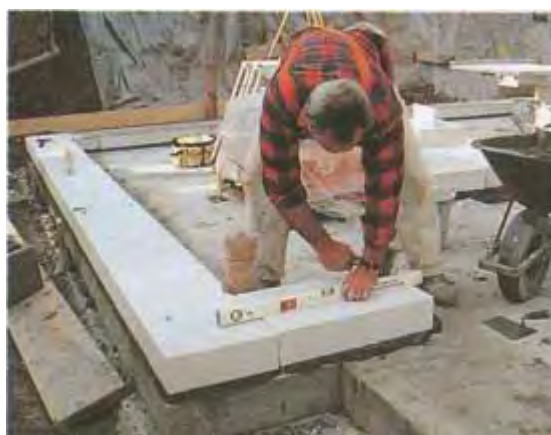
4 ноября, первый день команды строителей: в 11.00 утра уложен выравнивающий слой раствора.
