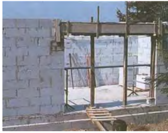
Дорогостоящие опалубки для перемычек делаются очень редко.
