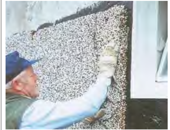
Для защиты от повреждений и лучшего отвода воды укладываются дренажные плиты.
