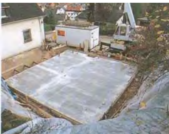
30 октября: фундаментная плита забетонирована, стройплощадка оборудована.
