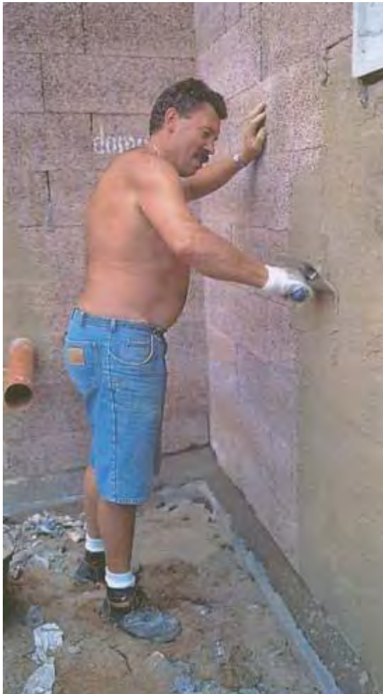
Подготовка к работам по гидроизоляции, выкружка на выступе фундамента, шпаклевка стен.
