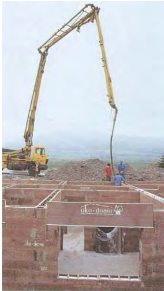
Бетон направляют в пустотелые стены с помощью насоса.
