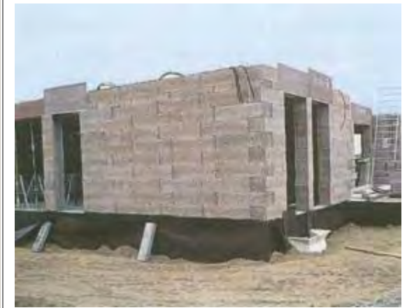
Засыпайте рабочее пространство траншеи лишь после возведения первого этажа.
