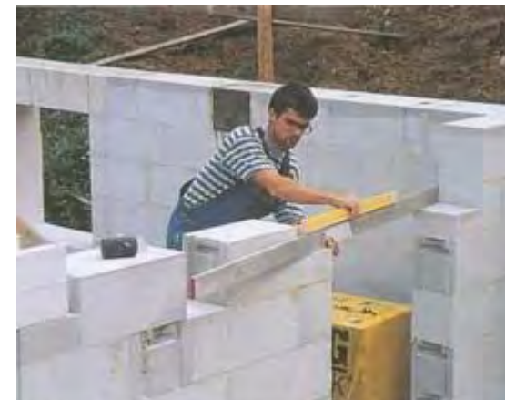
Подходят опоры? Неровности удобно
