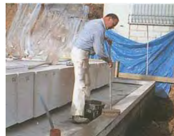
На выравнивающий слой наносится гидроизоляционная суспензия.
