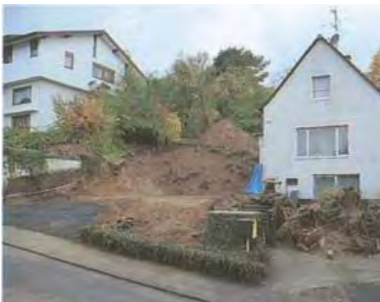
21 октября: вырыт котлован, покрыто щебнем место стоянки для автокрана.
